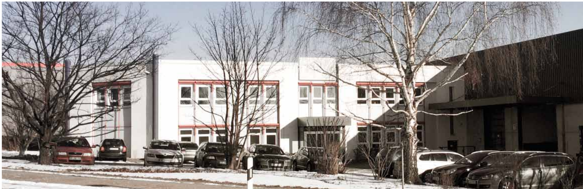
Eingangsbereich des neuen KRUG-Standorts in Meerane.
