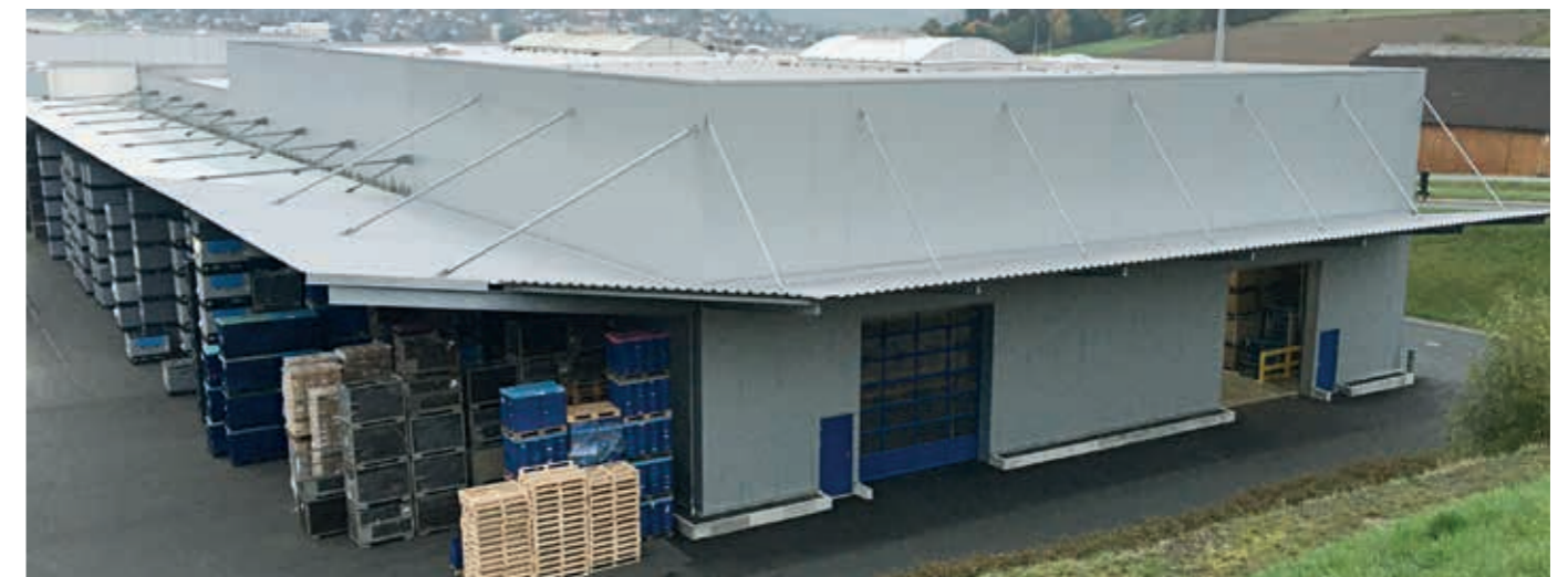
Der neue Anbau erhöht die Lagerkapazität deutlich.
